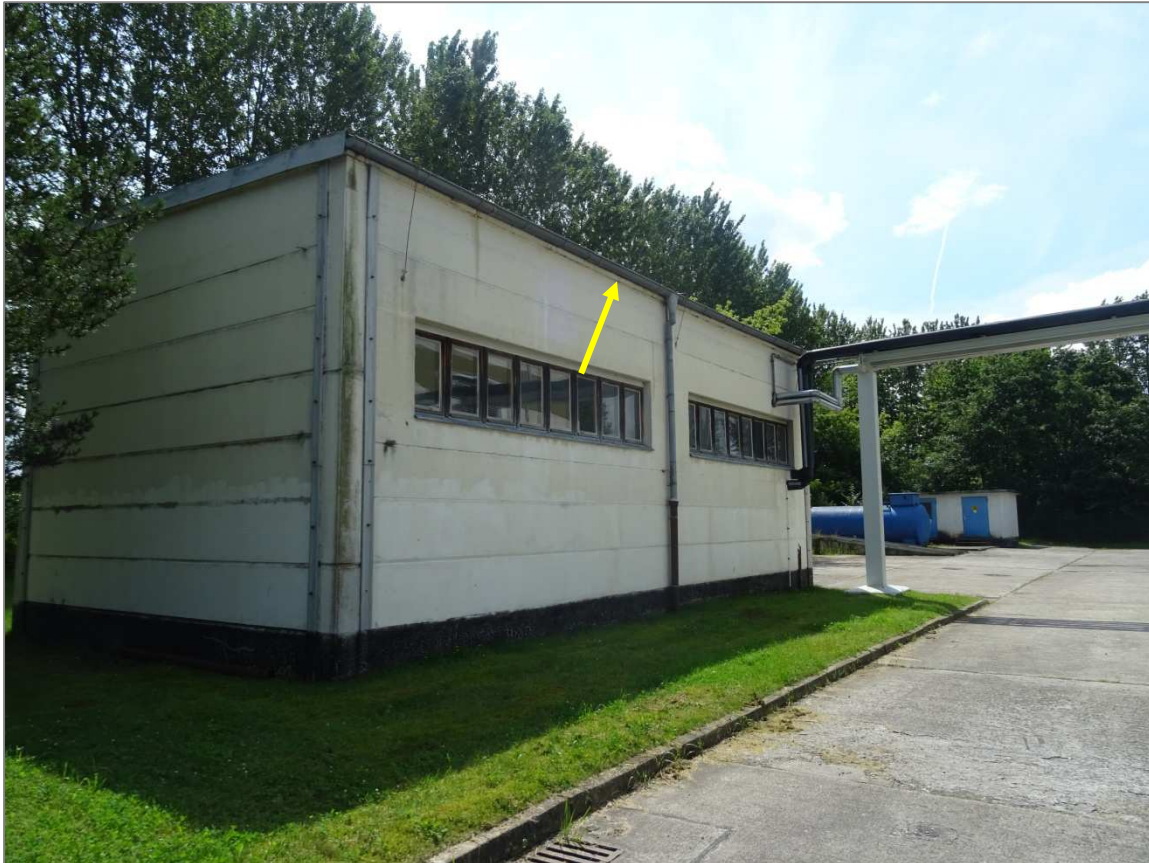
Abbildung 6: Brutplatz der Mauersegler im Nebengebäude des Blockheizwerkes, 19.07.2017.
